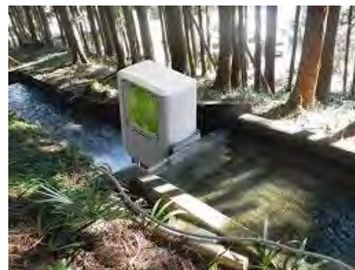
出展：相反転方式差型小水力発電機
